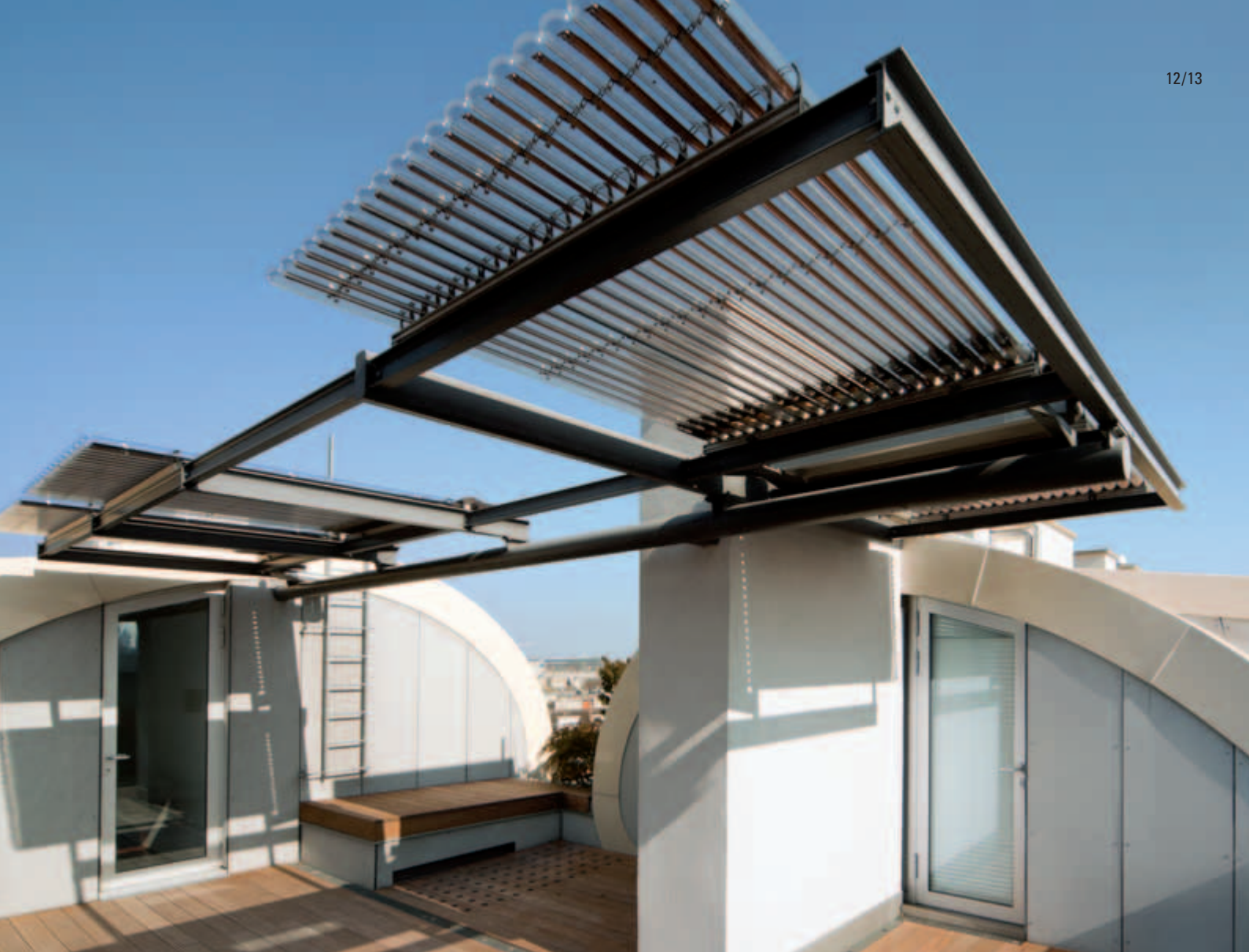
Príklad použitia zariadenia Vitosol 200-T – trubicové kolektory na fasáde.
